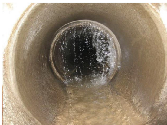
Figur 23 Eksempel på innlekking av fremmedvann
