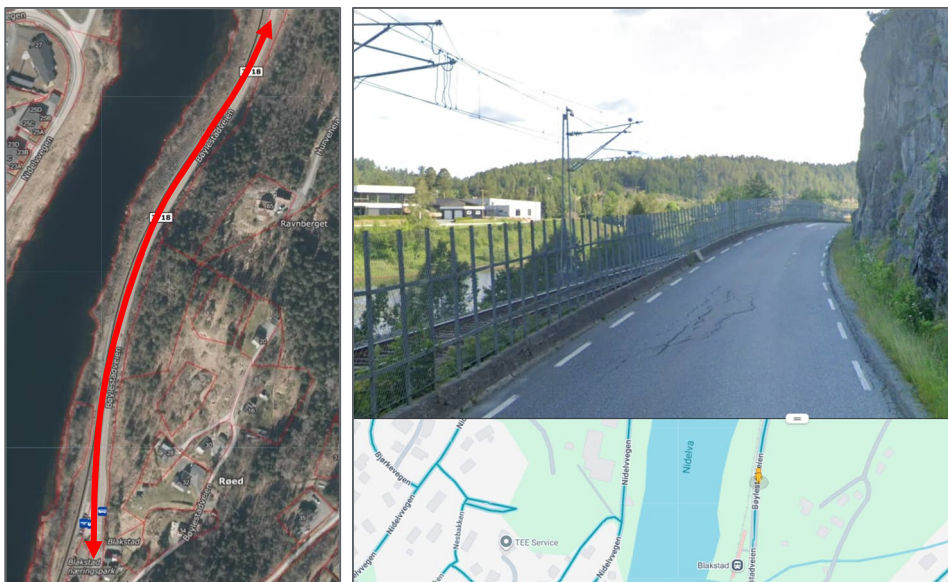
Figur 3-10: Strekning over omtrent 250 meter og i kurve, vegbredde 4-5 meter og uten møteplasser. Vegbanen ligger mellom toglinje og fjellskjæring. Møtesikt ikke i tråd med håndbokkrav. (Flyfoto: Finn kart. Gatebilde: Google Maps Street View, juli 2025)
