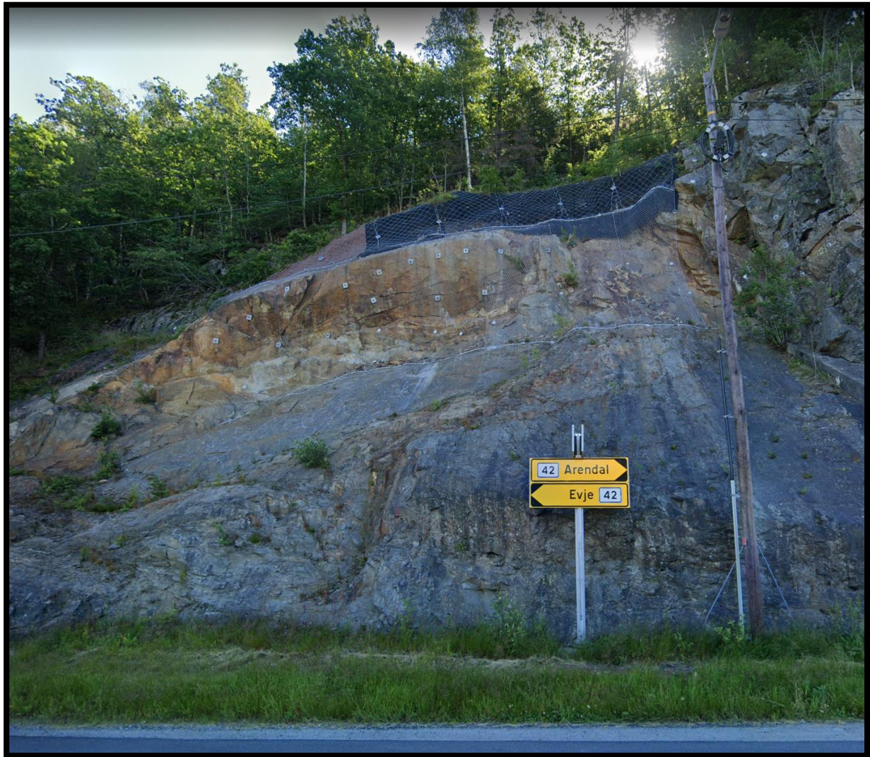
Figur 18. Bergskjæring pr. 30-60 etter rensk og sikring.
