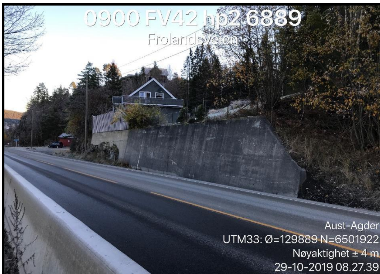
Figur 20. Betongkonstruksjon ved pr. 490-550 for å støtte opp løsmasser.
