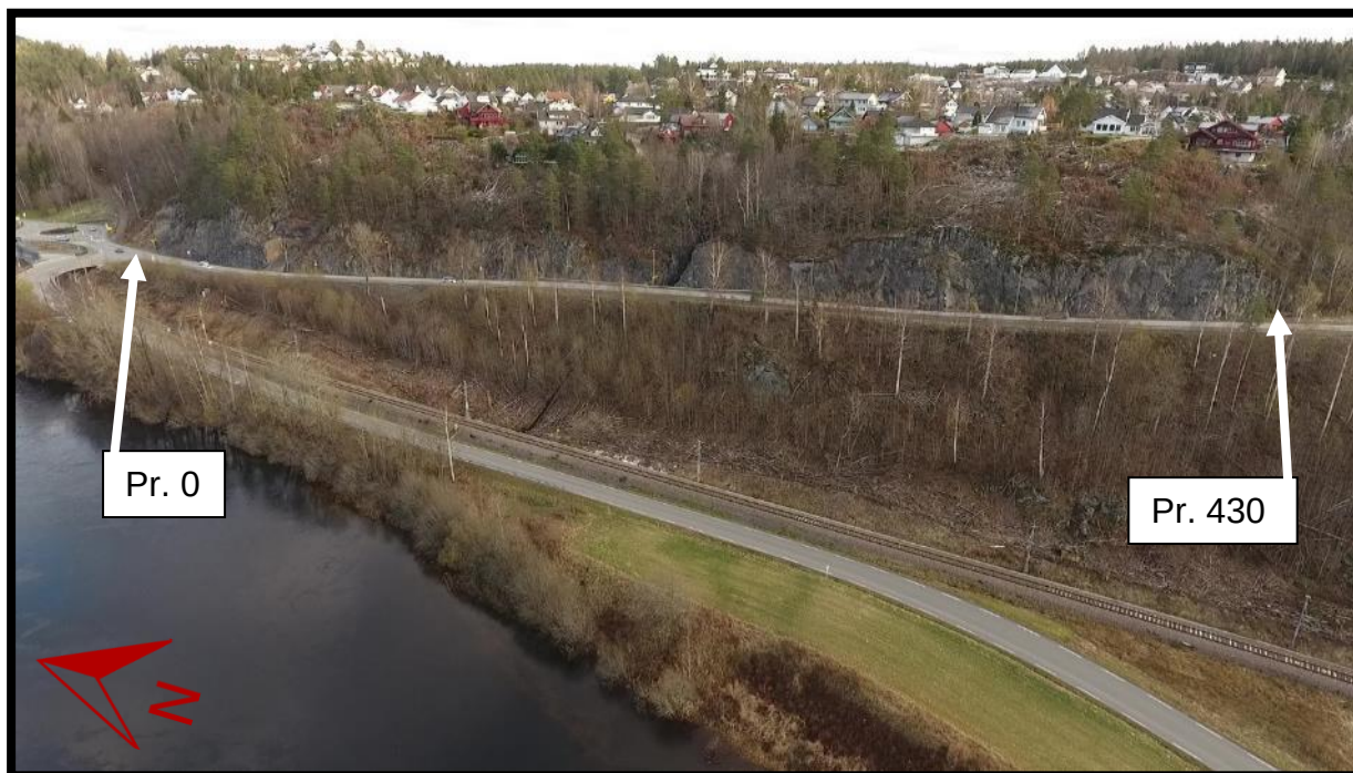
Figur 2. Dronebilde over bergskjæring 1.
