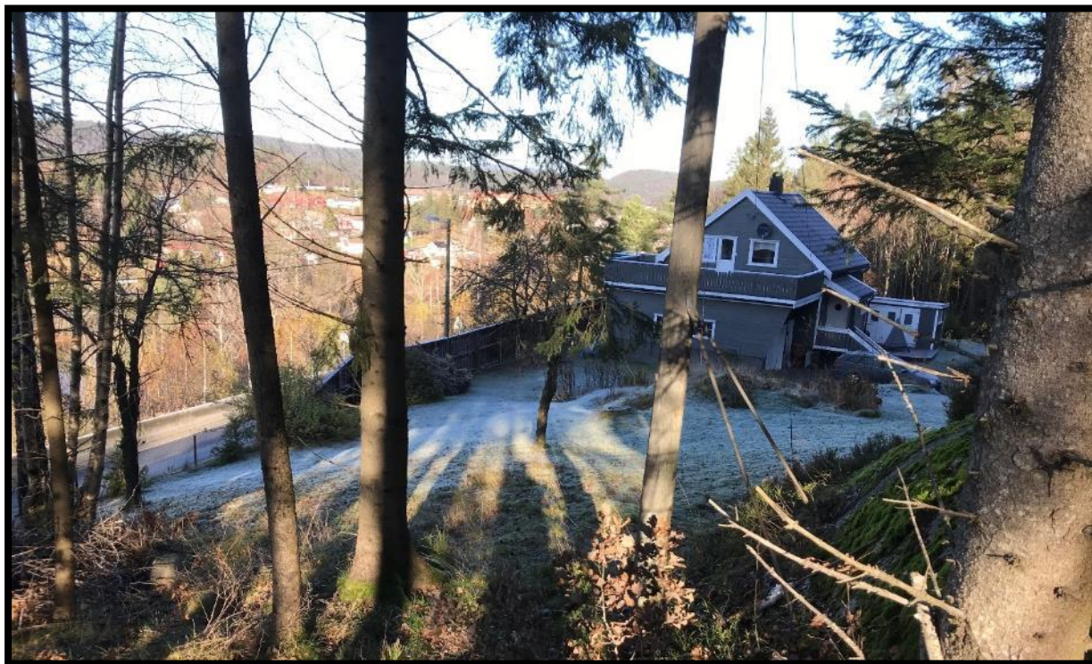
Figur 21. Bilde fra terrenget bak betongmur pr. 490-550. Bergblotning like nedenfor terrassen (ca. midt i bildet).
